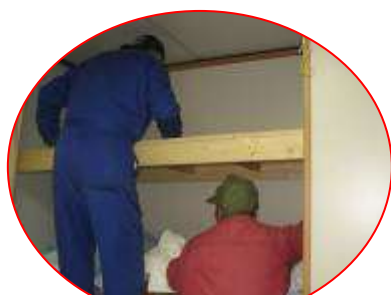
仮設住宅の押入れに棚設置
