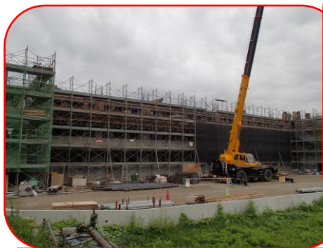
大船渡市立根町の関谷公営住宅
