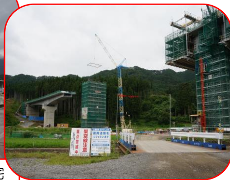
建設中の三陸沿岸道路
