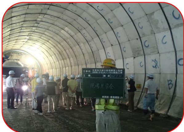
工事中の小石浜のトンネル内を見学
