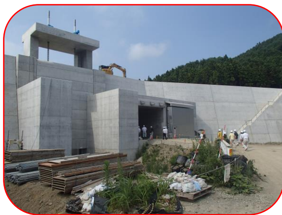
合足地区の水門と堤防
