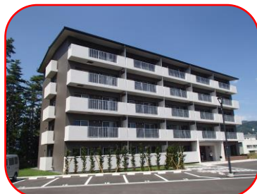
大船渡市営 赤沢アパート。鉄筋コンクリート造、5階建て、23戸。集会場がある。
