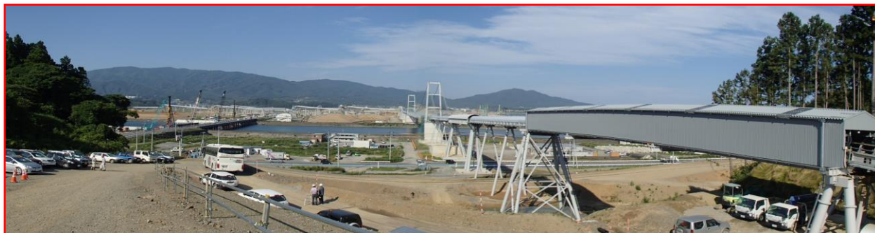
陸前高田市の工事現場
