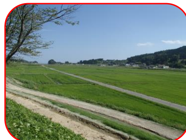
陸前高田市小友地区の県営ほ場整備事業気仙川地区 (ここは広田湾と大野湾からの波が押し寄せ、大きな被害が出た場所だった)
